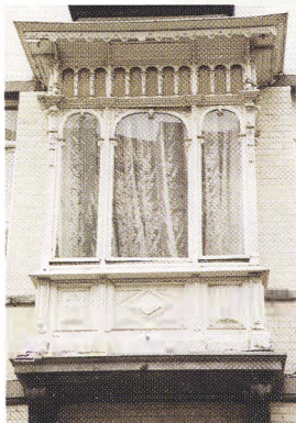
Erkers: worden steeds couranter en nemen vaak de plaats van balkons in. Vaak zijn ze van hout en hebben ze een zinken bedaking.
