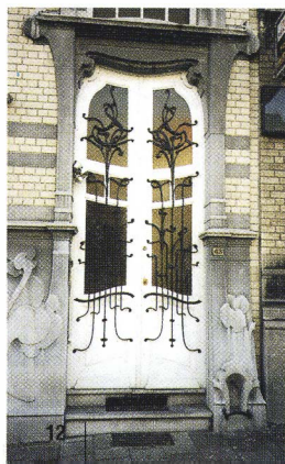
Deuren: de uitsnijding van de muuropeningen getuigt van een gedurfde originaliteit. De vensterkozijnen en het houtwerk van de deuren nemen nooit eerder geziene vormen aan. De deur wordt een "totaalkunstwerk" dat hout, glasramen en ijzerwerk samenbrengt.
