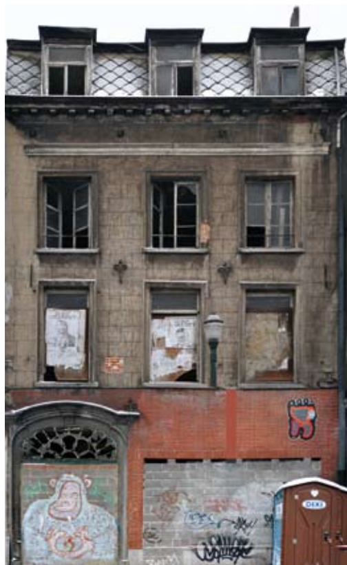
Timmerhoutkaai nr. 3, voorgevel (foto van de auteur © MBHG-DML).
