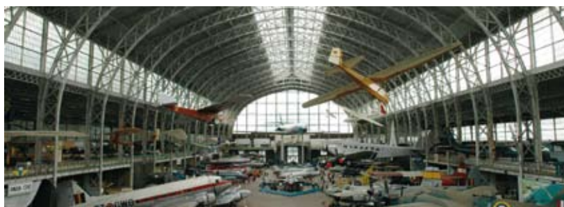
Het interieur van de luchtvaarthal (foto Regie der Gebouwen).
