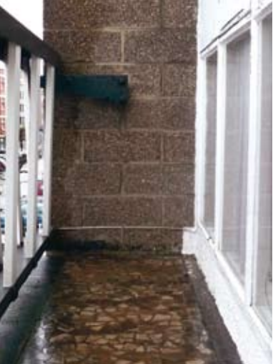
Detailopname terras appartement 2 in grestegels met balustrade in geplooid metaalplaten vóór restauratie, februari 2010 (foto van de auteur).
