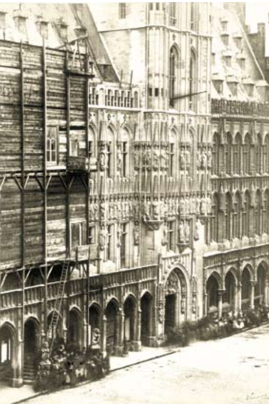
Detail van het Brussels stadhuis met stelling aan de gevel tijdens restauratie (foto E. Fierlants, verz. Broodhuis).
