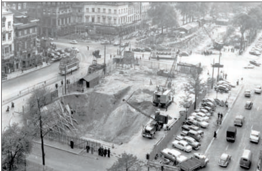
▲ Het graven van de tunnel onder het Louizaplein, 1956.
