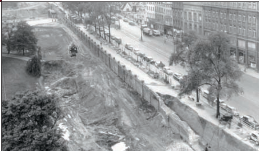
▲ De aanleg van de tunnel van de Kruidtuinlaan, 1957.
