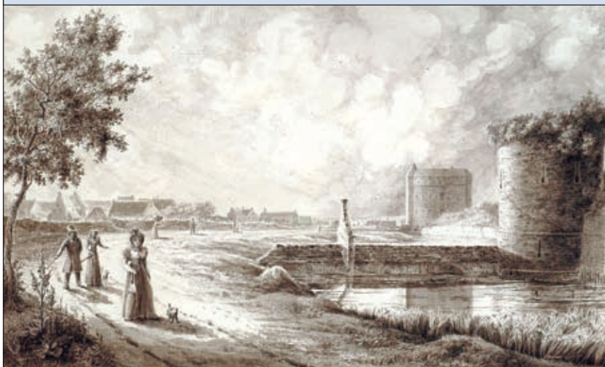
▲ Vitzthumb, P., Wandeling langs de stadsomwalling . Op het voorplan een middeleeuwse toren geïntegreerd in het ravelijn van Sint-Clara, 1824.
