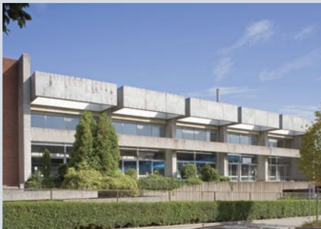
Het zwembad Louis Namèche in Sint-Jans-Molenbeek (arch. Brunswyck, Wathélet en Aelbrecht, 1972) is genoemd naar een voormalig minister van Openbare Gezondheid. In het gebouw dat typisch is voor het brutalisme van de jaren 1970, werden verschillende betontypes gebruikt en wordt de dragende structuur benadrukt. (Alfred de Ville de Goyet © GOB)
