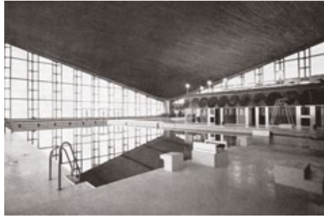
Het Longchamp-zwembad werd in 2008 door een brand geteisterd en nadien grondig gerestaureerd, waarbij de oorspronkelijke bekleding van het plafond in latwerk van cederhout werd verwijderd. La Technique des Travaux nr. 345, januari 1974. (© GOB - DCBSO)
