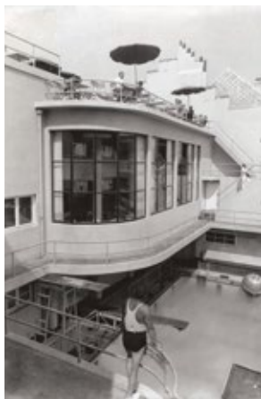
Bains Van Schelle . Net als het Palais de Glace , verandert het solarium in de winter in ijspiste. De losse vloer die op het zwembad wordt gelegd, is voorzien van een koelinstallatie die in twee uur tijd zorgt voor een ijslaag. (© Cercle d'Histoire de Saint-Gilles)
