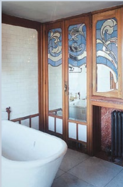
Badkamer in het Hôtel Solvay. De vloer in Carrarisch marmer contrasteert met de 'metro'-wandtegels en het houtwerk in mahonie. In de kast zit een WC verborgen. (Bastin-Evrard © GOB)
