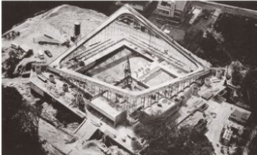
Luchtfoto van de dragende structuur van het Longchamp-zwembad, La Technique des Travaux nr. 345, januari 1974. (© GOB - DCBSO)
