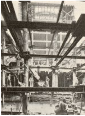
Badens van Brussel. De stabiliteit was de grote uitdaging van de werf: er waren 482 Franki-palen nodig voor de funderingen. La Maison , nr 2, februari 1954 – p. XXXIII. © GOB – DCBSO
