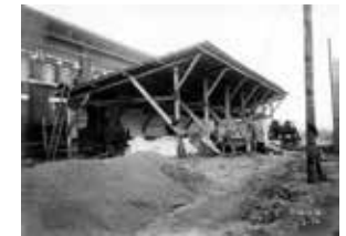
Installaties voor het elektrisch malen van mortel. (© SAB)
