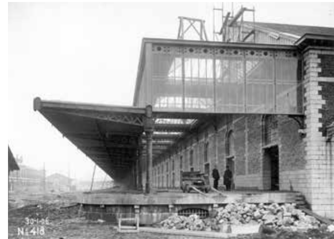
Het brede overdekte perron langs de westelijke gevel van het entrepot met sheddak in 1906. Door de latere verbreding van het gebouw werd het perron afgebroken en een dertigtal meter verder heropgebouwd. (© SAB)
