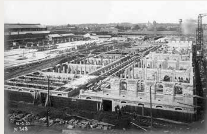
De funderingen van het Koninklijk Pakhuis zijn voltooid, evenals een deel van het metselwerk van de benedenverdieping. Links, langs het goederenstation, is de vloer van het toekomstig entrepot A zichtbaar. In de verte tekent zich het silhouet af van de kerk van Laken. (© SAB)
