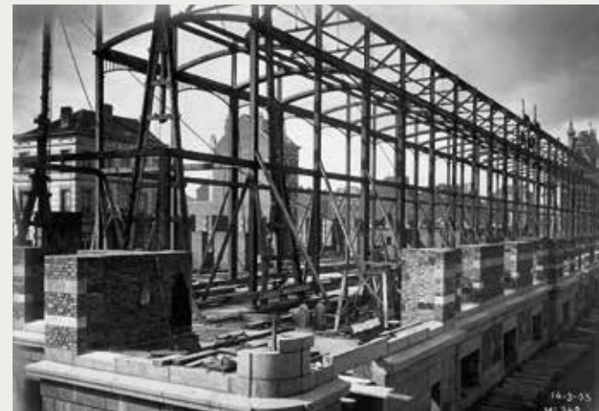
Bouw van het metalen skelet van de centrale hal van het douanegebouw. (© SAB)
