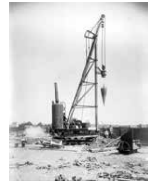
Het houten of metalen geraamte van een heilmachine dat diende als geleider voor een zwaar (giet)ijzeren gewicht, ‘mouton’ genaamd. Dit gewicht, dat meerdere meters omhoog werd gehesen door een stoommachine en vervolgens in vrije val neergelaten, dreef met zijn 1.200 kg geleidelijk de lange houten heipalen de grond in, bestemd om de funderingen in de zeer vochtige ondergrond van de site te stabiliseren. (© SAB)
