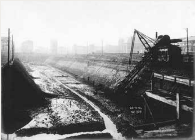
In het tweede deel van de uitgravingen voor het pakhuis is een baggergraafmachine waarvan de ketting met emmers wordt aangedreven door een stoommachine, bezig het talud af te schuiven door er sleuven in te graven. De met aarde en puin gevulde emmers worden achter de graafmachine uitgestort. (© SAB)
