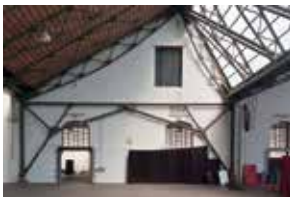
Detail van het scharnierende gebinte van de sheddaken. (A. de Ville de Goyet © GOB)
