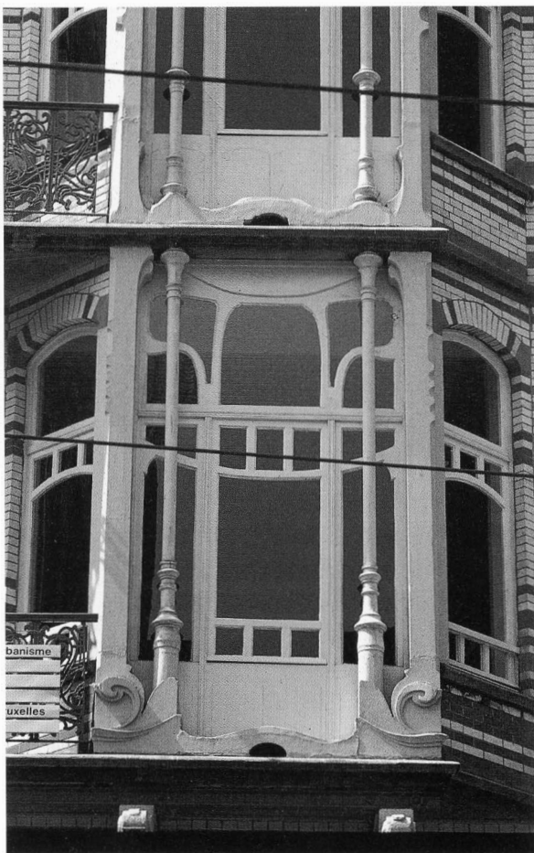
De Jaerlaan 9. Architect Strauven had een voorliefde voor ijzersmeedwerk, zoals blijkt uit de zeer kunstige borstweringen en de in het erkerraam ingewerkte zuiltjes. De invloed van zijn leermeester V. Horta is duidelijk merkbaar.
