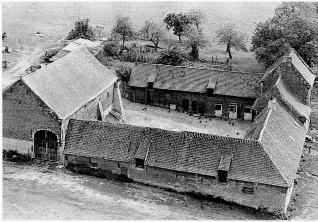
Zicht vanuit de hoogte op het Hof ter Musschen, eind jaren 1970, waarop de verschillende hoevegebouwen duidelijk herkenbaar zijn. Links het hoofdgebouw met drie onderscheiden niveaus. Vooraan de stallen met een plint in zandstenen breukstenen, waaruit blijkt dat dit gedeelte ouder is dan de andere gebouwen. Rechts de schuur uit 1741. Achteraan varkens- en paardestallen gebouwd in 1898.
