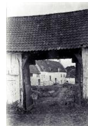
Ingangsportiek van de Stokkelhoeve in Sint-Pieters-Woluwe, afgebroken in het begin van de 20ste eeuw. Het gebouw stond op de hoek van de Orbanlaan en de Schermlaan.
