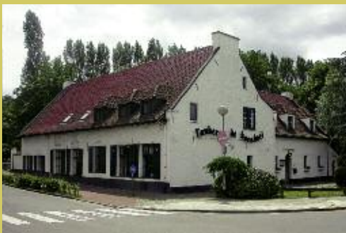
Een pannendak, muren bestreken met kalkwit en teer... zo zagen de meeste boerderijen eruit aan het begin van de 20ste eeuw. Hier L'Auberge de Boondael (Elsene), vandaag een restaurant.
