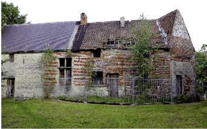
De laatste gebouwen van het Hof ter Coigne (17de-18de eeuw) in Watermaal-Bosvoorde.
