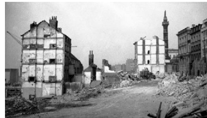
Opname van de site tijdens de slopingswerken van de restanten van het 17 de -eeuwse oratorianenklooster.
