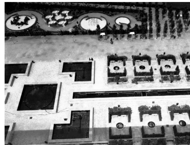
Zicht op de tuinen tijdens de inrichtingswerkzaamheden.
