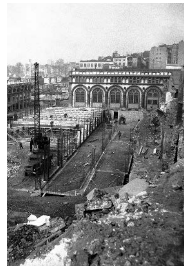
Bouw van de eerste fase van de ondergrondse parkeergarage. Op de achtergrond is de rechtervleugel zichtbaar van de overdekte markt van Cluysenaar, die nog niet is gesloopt.
