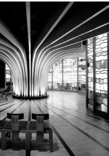
Centrale palmvormige kern van de plafondribben. Meditatiekamer van de Financiëntoren, toestand in 2004.
