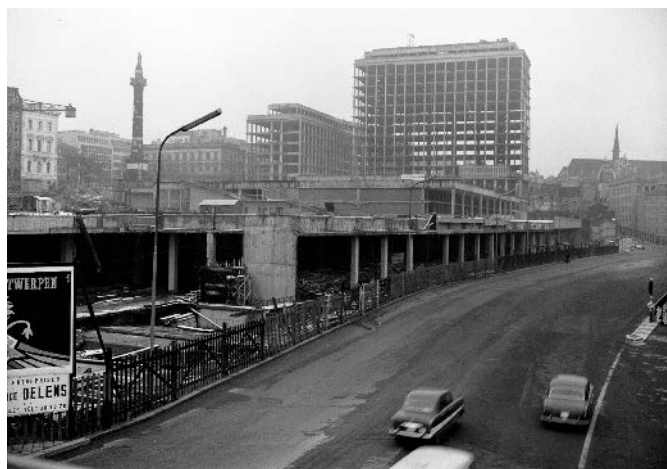
De esplanade en de Vesalius- en Esplanadengebouwen in aanbouw. Zicht op de Pachecolaan, omstreeks 1965.
