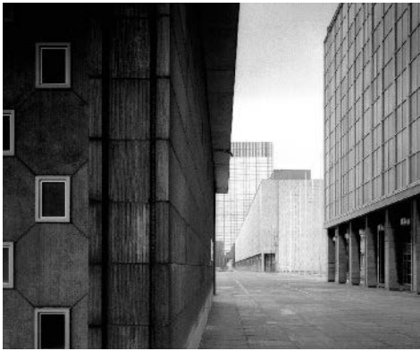
Detail van de compositie van de hardstenen bekleding van de buitenmuur, met vierkante modulaire vensters, onder de zuidelijke boog van het Esplanadegebouw.
