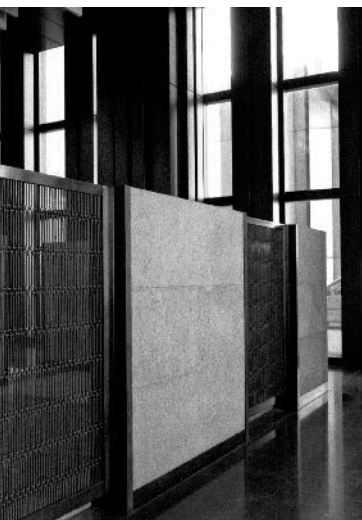
Ontvangsthal, toestand in 1985. Hardstenen afsluitingen van de ruimtes en traliewerk in messing.
