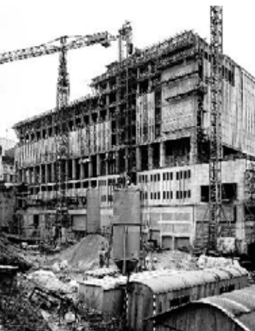
Het Arcadengebouw in aanbouw.
