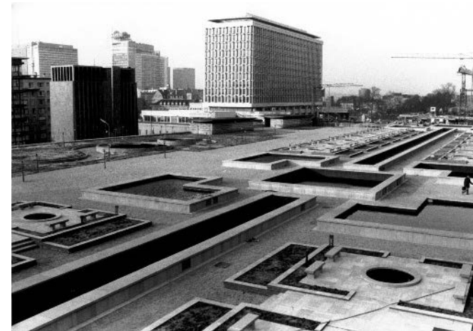
Zicht op de tuinen tijdens de aanleg.
