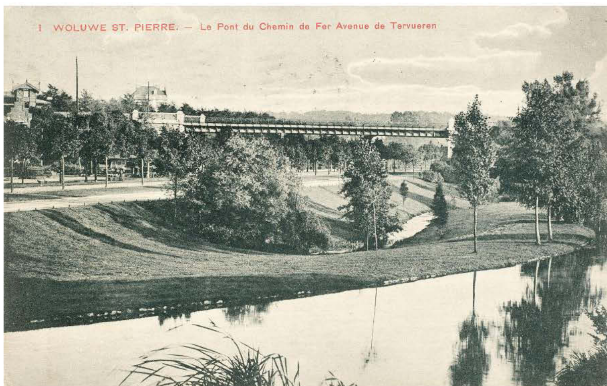
De spoorbrug en de Woluwe. Op de voorgrond bevindt zich de vijver van de waterval van het Woluwepark. Op de heuvel links is de treinstation Woluwe-Saint-Pierre-Avenue zichtbaar (vandaag afgebroken). (opname F. Walschaerts, Brussel, poststempel 1915)
