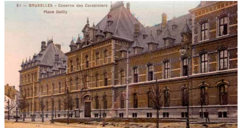
Daillykazerne, voorgevel op het gelijknamige plein.
