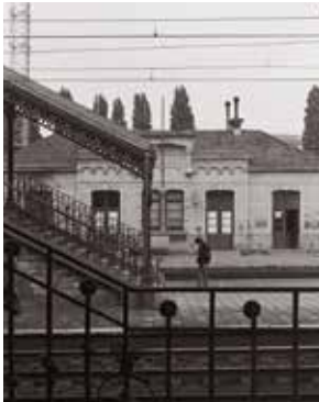
Het eerste station van Etterbeek (1880), vóór de bouw van de gebouwen langs de Oefenlaan. Men merkt de trappen die overblijven van het station uit 1906 dat omstreeks 1950 werd afgebroken.
