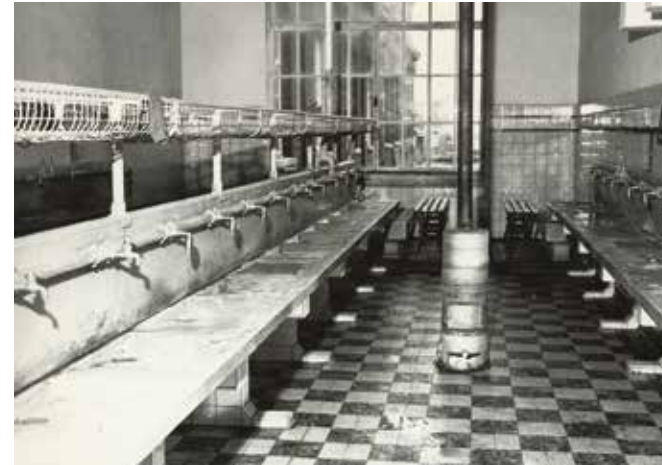
Foto van de sanitaire voorzieningen in de Rolinkazerne op het einde van de jaren 1960, opgenomen in het Domaniaal Renovatieplan om de verouderde staat van de militaire installaties te illustreren.
