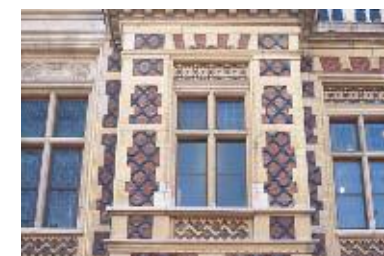
De architect ontwerpt vier rijkelijk versierde, polychrome gevels. Hij gebruikt daarvoor verschillende materialen.
