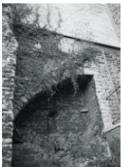
Recent zicht van de trap op boog, aan het begin van de Plebaantoren.
