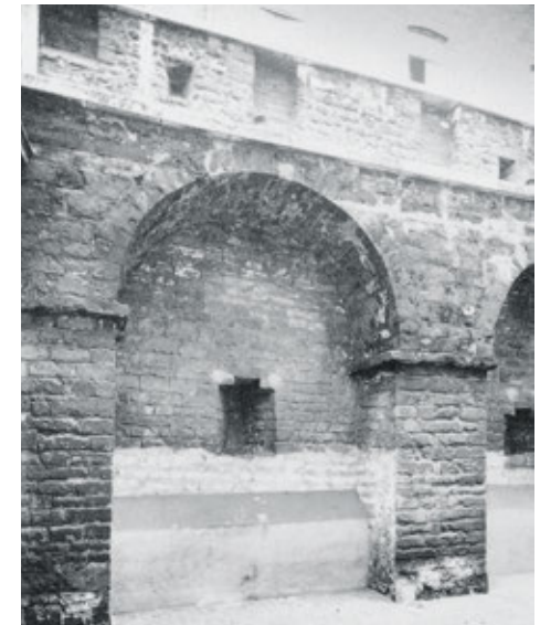
Het stuk walmuur intra muros in de Eikstraat na de restauratie, in 1956.
