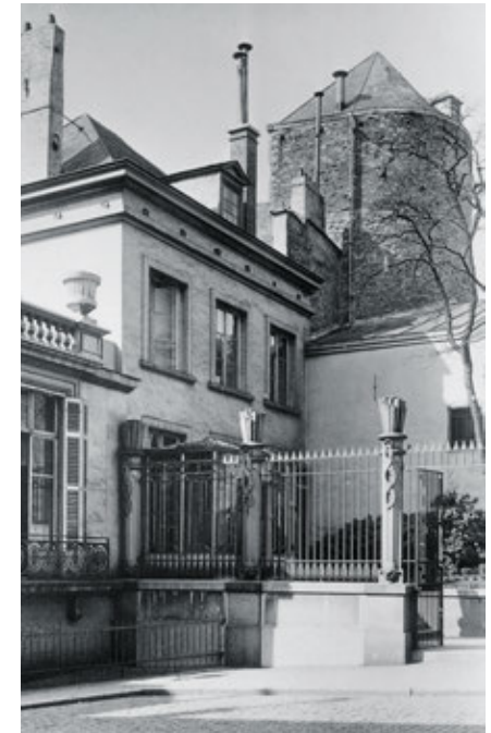
De Matthieutoren van de eerste omwalling werd afgebroken in 1908 om het bankgebouw, waartoe het behoorde, uit te breiden.
