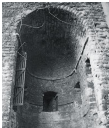
De Plebaantoren: de overwelfing op de benedenverdieping en detail van de schietgaten.
