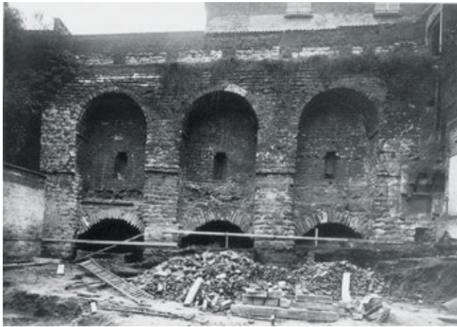
Overblijfselen van de eerste omwalling intra muros, Wildewoudstraat.
