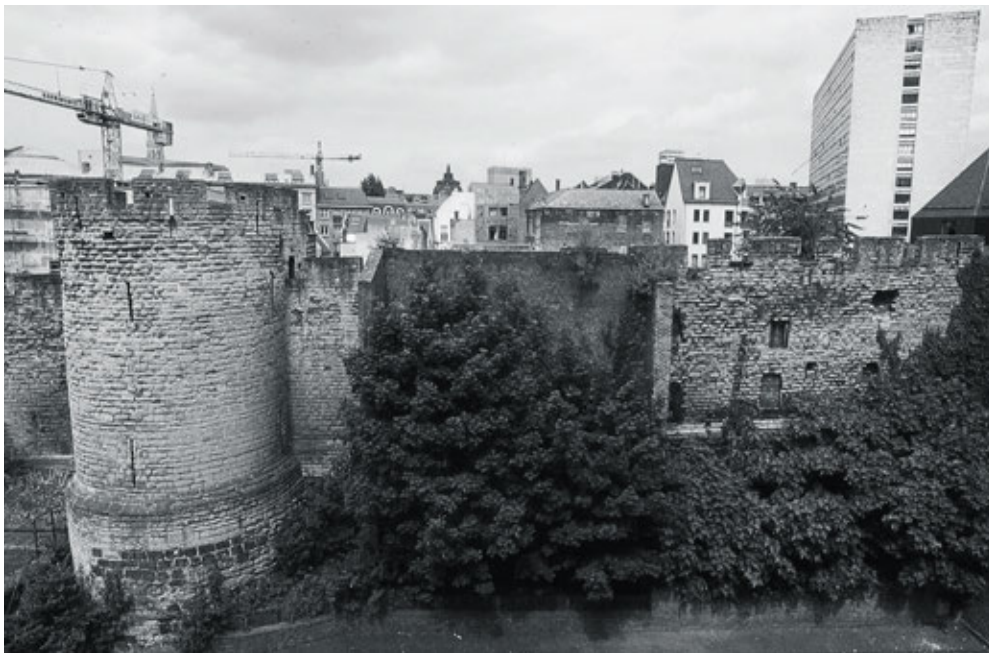
De Villerstoren extra muros en de walmuur in oostelijke richting.
