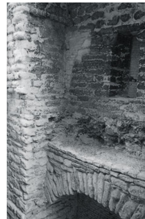
Detail van de walmuur in de Wildewoudstraat: de muur tussen de twee pijlers rust op een funderingsboog en is voorzien van een schietgat.
