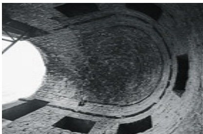
De Hoektoren, halfkoepelbogige overwelling van de eerste verdieping.
