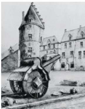
De Zwarte Toren domineerde het Kraanplein aan het Sint-Katelijnedok.
