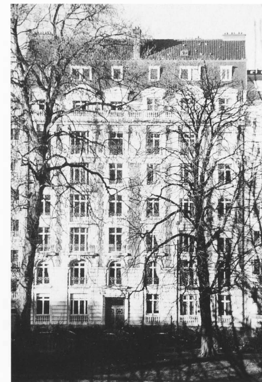
Aan de Maria-Louizasquare n 8 werd het eerste moderne appartementsgebouw van de wijk gebouwd. Het was ook de eerste aanslag op de architecturale eenheid van de wijk.
