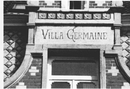
Baksteenpatronen in verschillende kleuren, faiëncetegels, mozaïek en blauwe hardsteen verlevendigen de gevel van huis nr 24 aan de Palmerstonlaan. Dit huis uit 1897 werd bewoond door het echtpaar Houssa, de ouders van Germaine.
