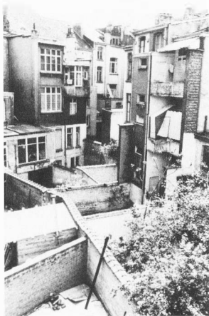
Zicht op de binnenkant van het huizenblok tussen de Filips de Goede en de Orteliusstraat en de Maria-Louiza- en Gutenbergsquare in 1973. De achtergevels lijken op reuzenkasten waarvan sommige lades halfopen zijn blijven staan.
