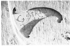
Handtekening van Gustave Strauben op de onderbouw van huis nr 51 in de Van Campenhoutstraat, in overeenstemming met de Art Nouveau-stijl van de gevel. Gedeeltelijk beschermd op 19-02-1984 en 02-07-1992.
