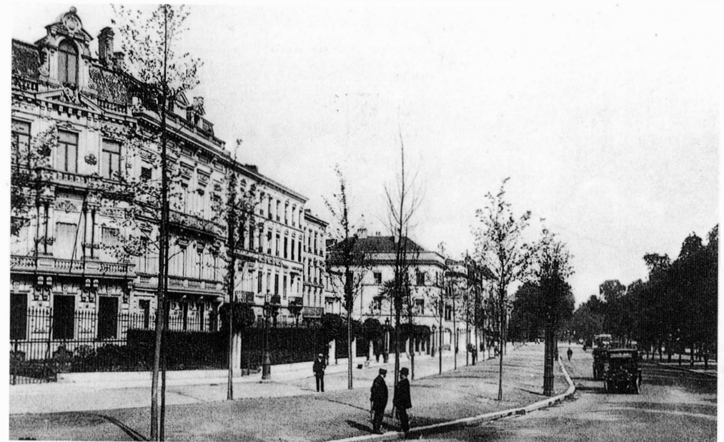
Regentlaan, bebouwd met prestigieuze herenhuizen.
