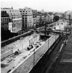
Het graven van tunnels onder de kruispunten (hier dat van de Wetstraat) was een noodzakelijke voorwaarde voor de heraanleg van de ringlanen in stedelijke autosnelwegen, zoals beslist in het vooruitzicht van de Expo '58.
