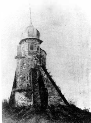
De watertoren bij de Leuvensepoort voorzag de bovenstad van water.
