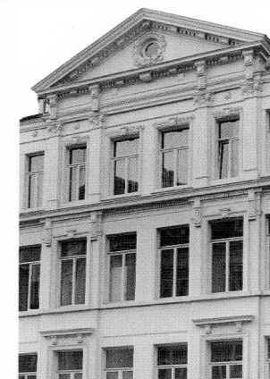
Hoekpand onder fronton in de Onderrichtsstraat en Koningstraat.
