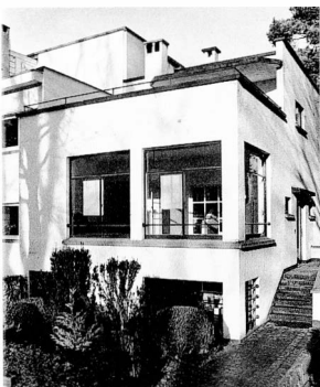
Dieweg 292. Deze kleine woning, in 1933 door H. van de Velde gebouwd voor prof. G. Lagasse, getuigt van de nieuwsgierigheid en de constante vernieuwingsdrang waarvan deze architect zijn hele lange carrière blijk heeft gegeven. De witte muren zonder enige versiering, het terras en het platte dak, alsook de intelligente schikking van de binnenvolumes situeren dit huis onmiskenbaar in de modernistische stroming van de jaren 1930.
