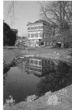
Deze kleine vijver is ongetwijfeld ouder dan het Observatorium. Hij vervult niet alleen een esthetische, maar ook een praktische functie en wordt mede daarom in stand gehouden. Indien er ooit in een van de gebouwen brand zou uitbreken, heeft men bluswater bij de hand.
