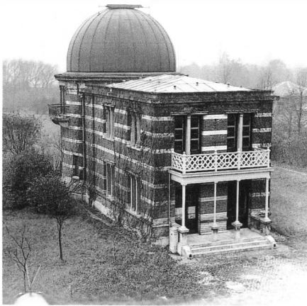
De Gautier-equatoriaalkijker en het platform voor zonneaarnemingen. Dit bevallige paviljoen met balkon (in de trant van de landhuizen zoals er in de omgeving heel wat zouden worden gebouwd) en de toren, waaraan recentere constructies zijn aangebouwd, dateren uit het begin van deze eeuw, waarschijnlijk uit de periode 1904-1909.
