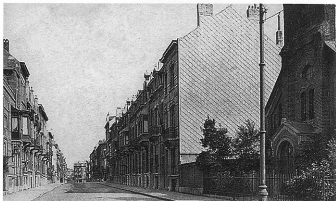
Tot in 1928 stond op de hoek van de rue de la Culture (Franz Merjaystraat) en de Hervormingsstraat de kapel die gediend had als voorlopige kerk van de Drievuldigheidsparochie. Na de voltooiing van het eerste deel van de definitieve kerk en de inwijding ervan in 1895 werd de kapel enige tijd gebruikt door de paters barnabieten alvorens te worden afgestaan voor de protestantse eredienst.
