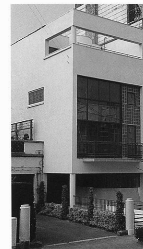
Persoonlijke woning van Paul-Amaury Michel, Jules Lejeunelaan 69, 1935-1936. De architect was nauwelijks 23 jaar toen hij dit verbazingwekkende huis bouwde dat helemaal uit gewapend beton, glas en metaal bestaat.
