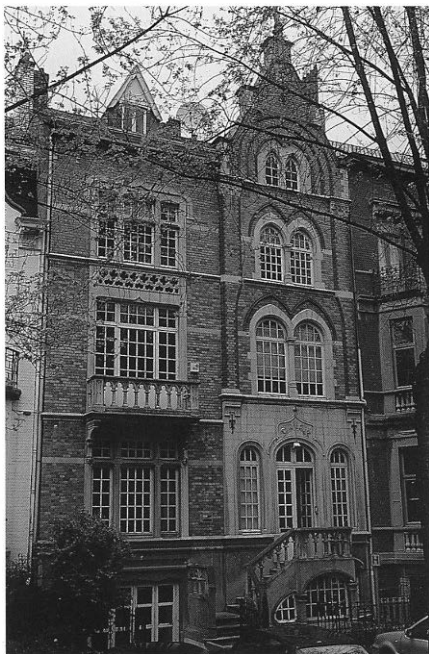
Molièrelaan 64 in Vorst, 1910. De gevel van deze woning vertoont een overvloed aan neogotische elementen zoals de spitsbogen en accoladebogen, de drielobbige motieven van de balustrades, het klaverbladfries, de dakkapellen, enz.
