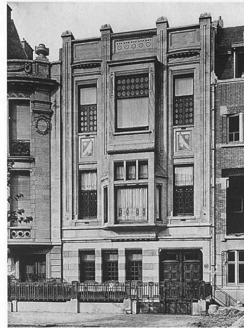
Het smeedwerk, de glasramen en de mozaïekpanelen met gestileerde bloemen en vogels van de woning aan de Molièrelaan 172 zijn kenmerkend voor de architectuur van Jean-Baptiste Dewin. Zowel het decor
