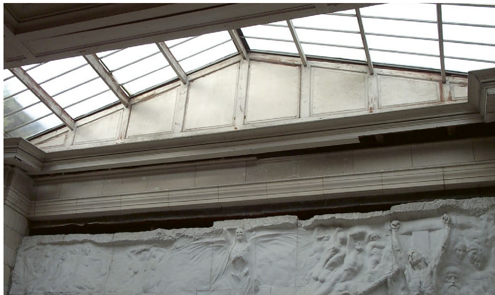
Het Paviljoen van De Menselijke Driften, arch. Victor Horta. Het reliëf vóór de restauratie: de omlijsting in Euvillesteen boven het reliëf werd gedemonteerd in 1980. Foto genomen in 2003. (© Regie der Gebouwen)
