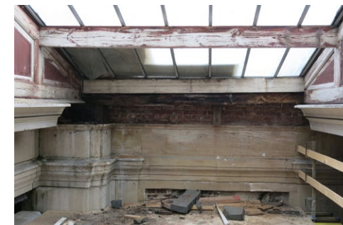
Het glazen dak tijdens de restauratiewerken, 2013*.
