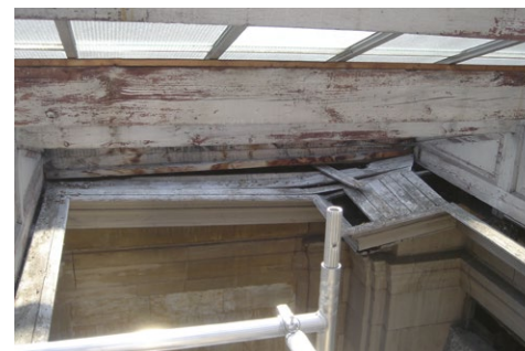
Glazen dak vóór de restauratiewerken, 2005*.
