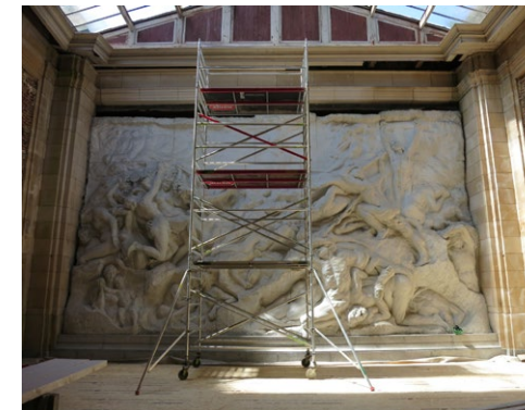
Binnenaanzicht, tijdens de restauratie*.
