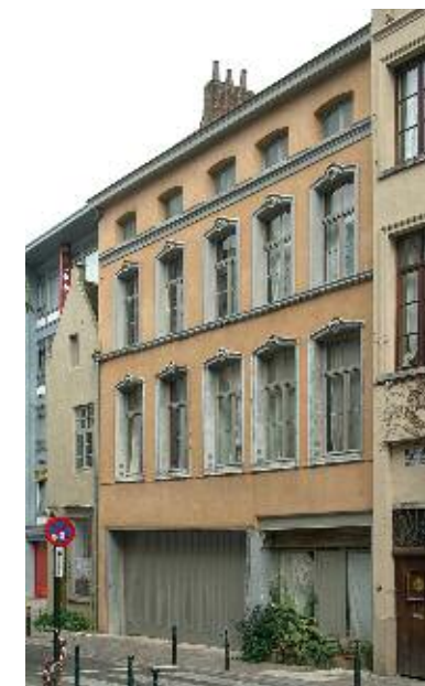
Herenhuis in de Huidevettersstraat nr 88. De hardstenen omlijstingen van de vensters met bekronende rocaillesleutel getuigen van een verfijnde soberheid.
