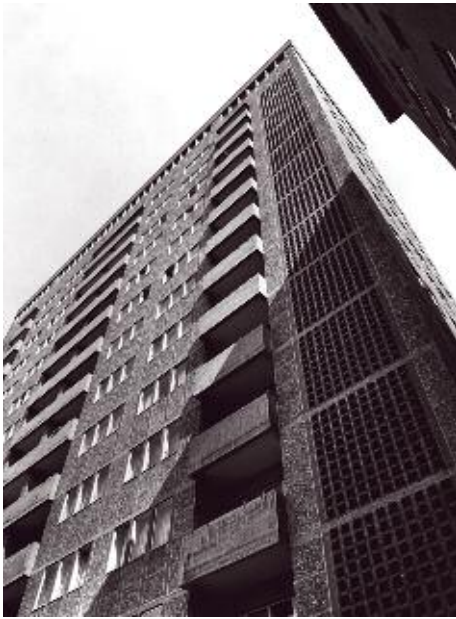
De Van Nueten-toren aan de Hoogstraat tegenover het Sint-Pietersziekenhuis. Deze 13 verdiepingen hoge woontoren bevat naast appartementen ook gemeenschappelijke voorzieningen zoals een crèche.
