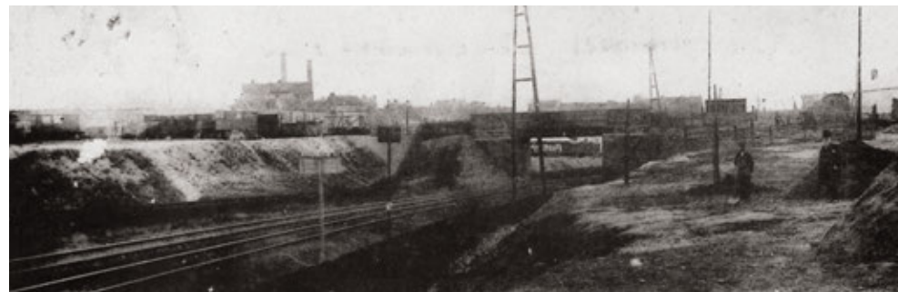
Verplaatsing van de ringspoorweg naar een sleuf: op de hoge berm rechts op de foto is men bezig met de grondwerken voor de E. Van Den Puttelaan, de toekomstige Voltairelaan. De in 1903 geplante bomen zijn twee meter te laag!
