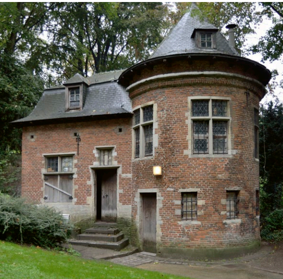
De toren van Eggevoord in het Leopoldpark (Brussel-Uitbreiding). (© urban.brussels)
