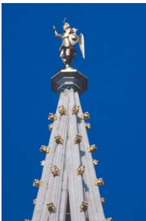
Beeld van Sint-Michiel die de demon verplettert, origineel uit 1455. Het beeld dat als een windwijzer op de spits van het stadhuis stond, is vervaardigd uit platen gehamerd koper bevestigd op een ijzeren skelet. Sommige volle delen zoals de handen, het kruis en de klauwen van de demon zijn van gegoten messing; het geheel was met bladgoud verguld. (V. Everaerts © MSB)
