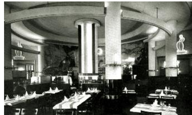
De Café de l'Horloge , hoek van de Elsense Steenweg (Naamse Poort) in Brussel. René Ajoux architect, rond 1930.
