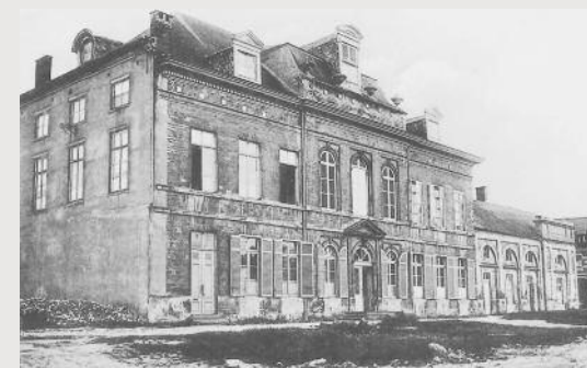
De noordelijke gevel vóór de restauratie.
