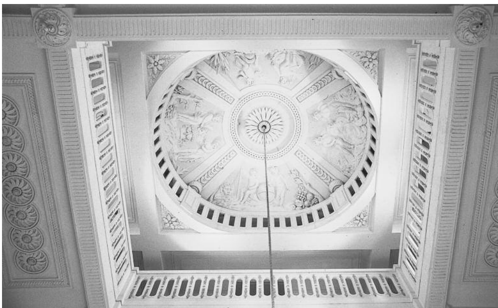
De koepel na de restauratie van 1968, zonder de ontlastingsbogen.
