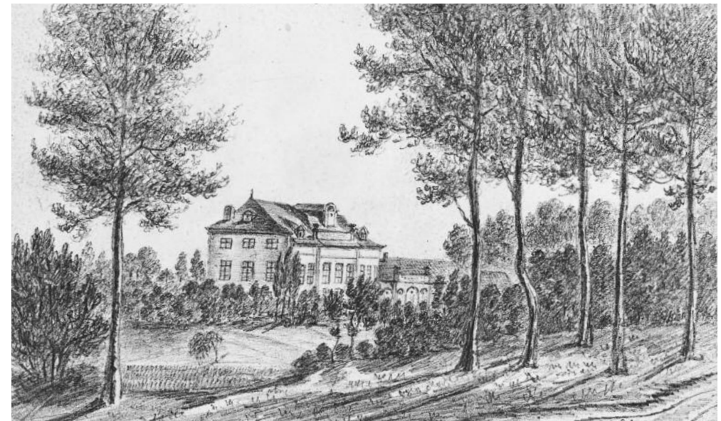
De noordelijke en noordoostelijke gevels vanaf het park. Tekening van Mastræten, omstreeks 1825.
