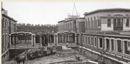
Het paviljoen heelkunde [C6] tijdens de bouw. (foto R.V. Duquenne, ACPASB)
