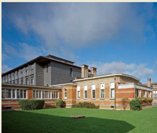
Op de achtergrond de nieuwe hospitalisatievleugels. (project Philippe Samyn & Partners, foto M.-Fr. Plissart)
