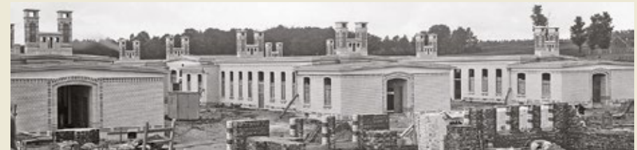
De paviljoenen in aanbouw met hun 'woud' van ventilatieschoorstenen op het dak. (foto R.V.Duquenne, AOCMWB)
