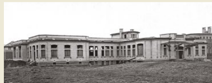
Het paviljoen kinderheelkunde (B) in het stadium van de voltooide ruwbouw. (foto R.V. Duquenne, AOCMWB)
