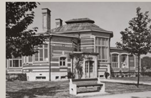
Het paviljoen Depage in 1925. (AOCMWB)
