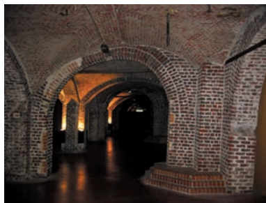
Afb. 16 Randkolommen uit het lood en geknikte bogen en gewelven in de kelder (© T.ar.S. bvba).
