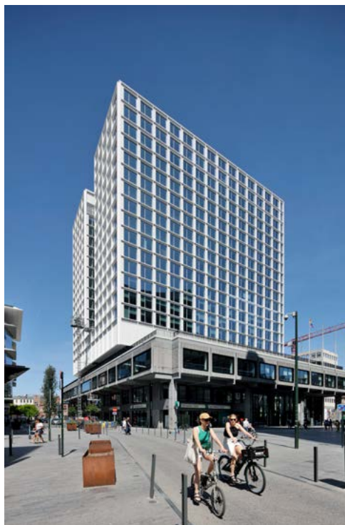
AFB. 1B Multi (voormalige Philipstoren), Anspachlaan 1, Brussel, 2023 (© immobelgroup).
