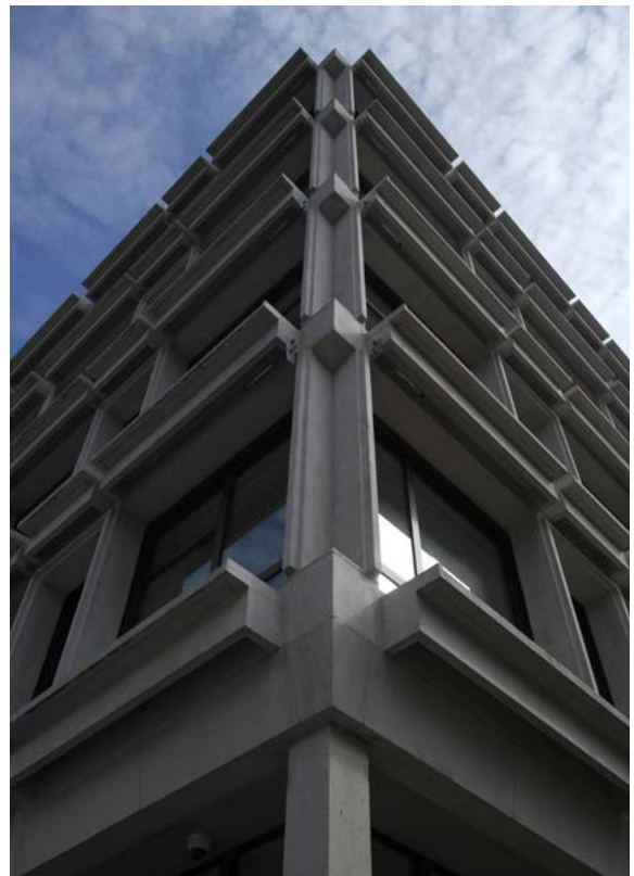
AFB. 3B Detail van de nieuwe gevelstructuur (T. Verhofstadt © urban.brussels).
