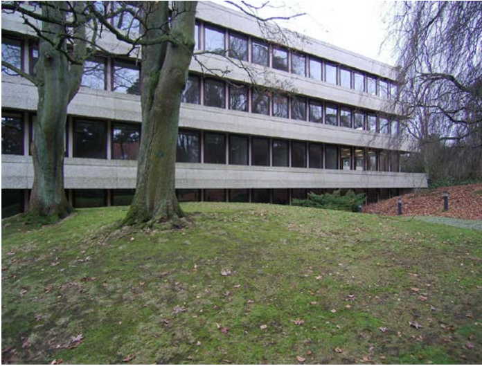
AFB. 1A Het voormalige BASF kantoor, Hamoirlaan, Ukkel (© Diener & Diener).
