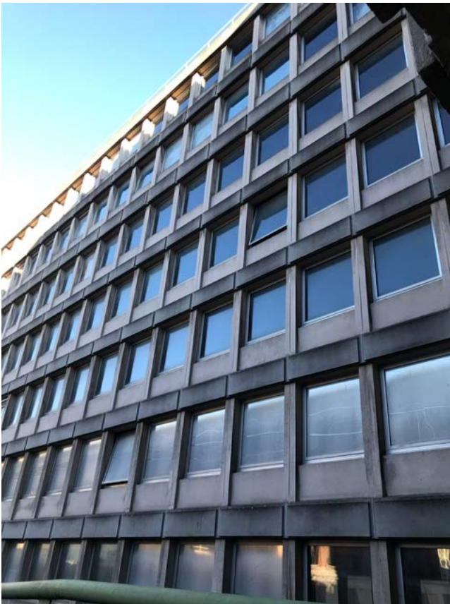
AFB. 4 Gevel in architectonisch beton (© D. Stiernon).
