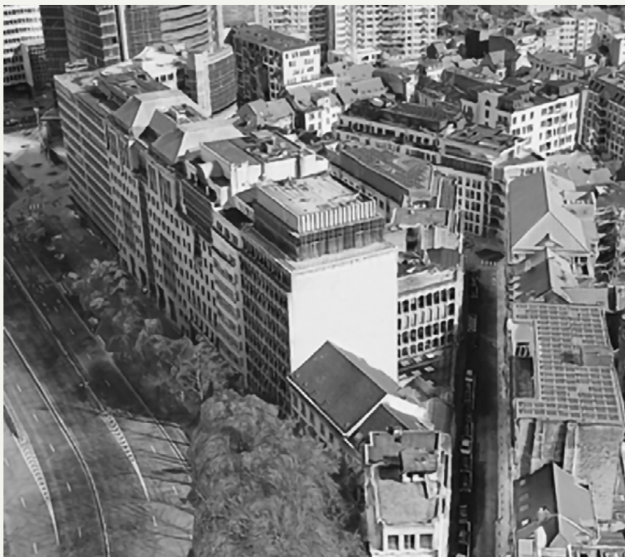
AFB. 5 Het L-vormige gebouw, met een gevel van betonnen prefabelementen en een optopping van twee verdiepingen, verbindt de Kunstlaan met de Liefdadigheidsstraat (Leo Robini en Shana Brao, foto Kunstlaan, 2023, ontwerpstudio Atelier Reconversion aan de ULiège).
