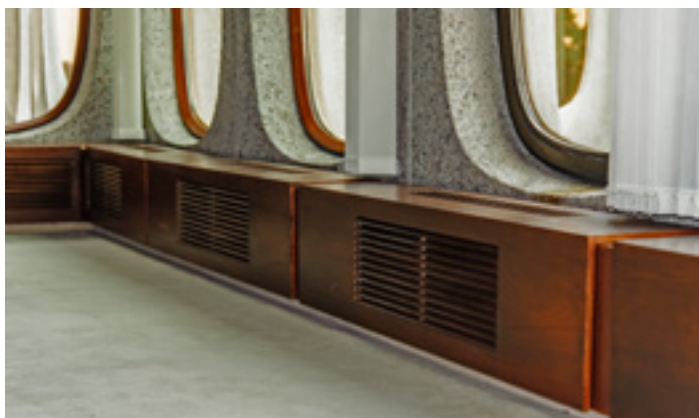
AFB. 8B De houten bekleding van de verwarmingsconvectoren werden behouden en gerestaureerd (A. de Ville de Goyet, 2018 © urban.brussels).
