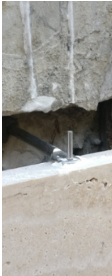
AFB. 2C Het bevestigingssysteem van de nieuwe travertijn bekledingsplaten wordt aangepast aan de huidige veiligheidsnormen (P.-Y. Lamy, 2022 © urban.brussels).
