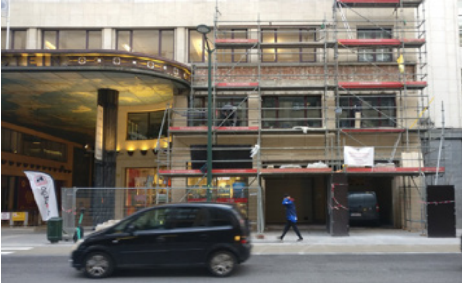
AFB. 2A De gevel van de Ravensteingalerij kant Kantersteen met de verwijderde travertijn bekledingsplaten (P.-Y. Lamy, 2022 © urban.brussels).
