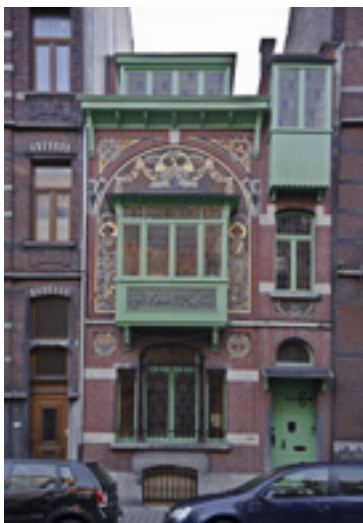
AFB. 1B Gebouw aan de Georges Moreauststraat nr. 170 in Anderlecht (A. de Ville de Goyet, 2022 © urban.brussels).
