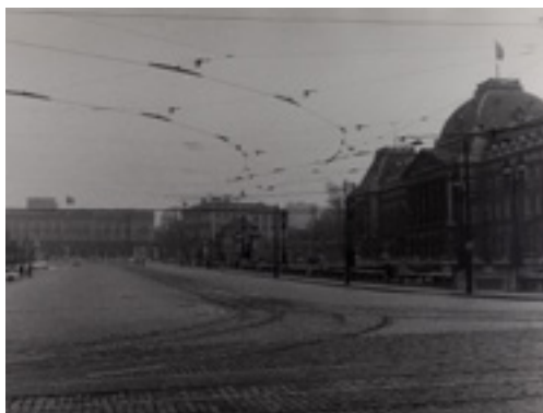
AFB. 12A Eén van zeven geannoteerde foto's van verschillende uitzichten op het Paleizenplein, en tekeningen met de verschillende idealiter op te leggen vrijwaringen.1968 (© urban.brussels, afdruk AL 270).
