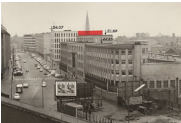
AFB. 9B De impact van het volume van het geplande gebouw is zorgvuldig nagegaan, vanaf drie verschillende punten op de esplanade, om tot de slotsom te komen dat deze impact aanvaardbaar is (© SAB, OW 73227).
