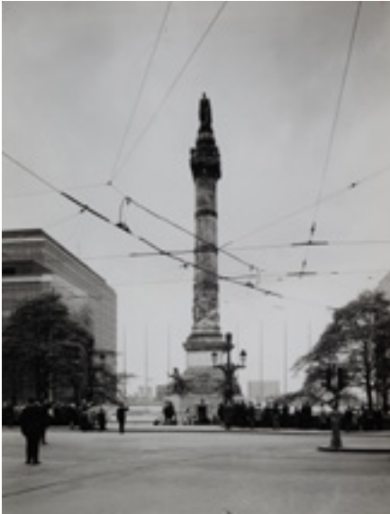
AFB. 6B Overdruk van de visuele impact van de Philipstoren (gebouwd, links) en het Continentalhotel (gepland, rechts) op de achtergrond van de Congresskolom (© urban.brussels, afdruk AL - 186).
