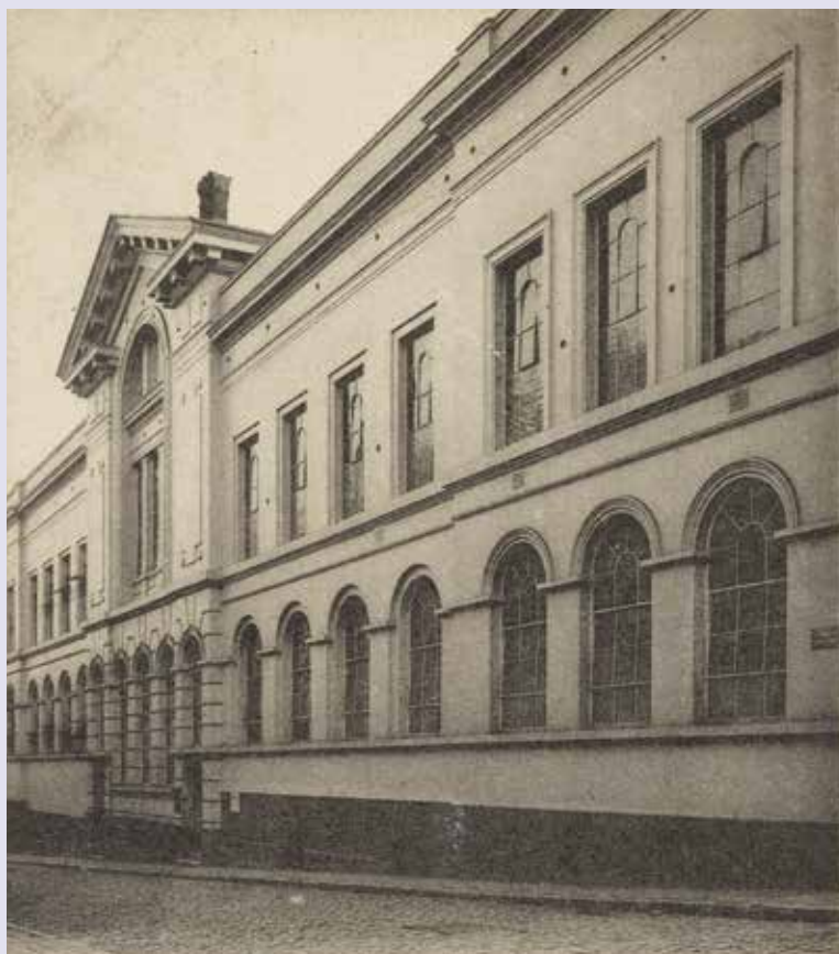
AFB. 1 Gemeenteschool Sint-Joost-ten-Node, 1856-58 naar ontwerp van gemeente architect Vanderauwera, waar vanaf 1864 de école des arts du dessin gehuisvest was (Verzameling Belfius Bank-Académie royale de Belgique © ARB - Urban.brussels)
