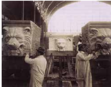
AFB. 8 Steenkappers van het bedrijf Beernaert aan het werk in de voormalige machinehal Cockeril, loods voor de werf van het Jubelpark, ca. 1904- 1905 (Ministerie Openbare Werken).
