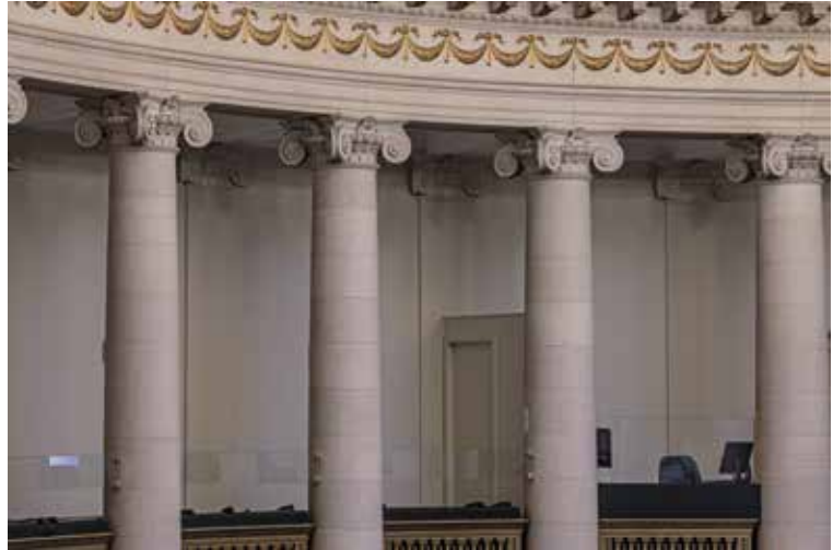
AFB. 13B De kapitelen in de zaal van de kamer van volksvertegenwoordigers zoals uitgevoerd door Houtstont (A. de Ville de Goyet, 2020 © urban.brussels).
