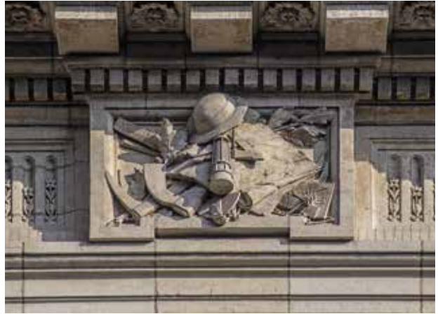
AFB. 3B Reliëf 'mijnbouw' op de gevel van het Hotel van de gouverneur, uitgevoerd door Houtstont (A. de Ville de Goyet, 2019 © urban.brussels).
