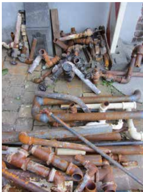
Gedemonteerde buizen en kranen vóór hun vervanging (foto van de auteur).
