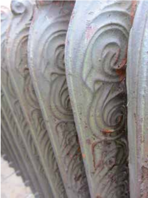
Achterkant van de radiator (model Perfection ) in de voormalige studiekamer van Huis Solvay zijn de oorspronkelijke kleuren: afgewreven bleekgroen op donkerbruin (foto van de auteur).
