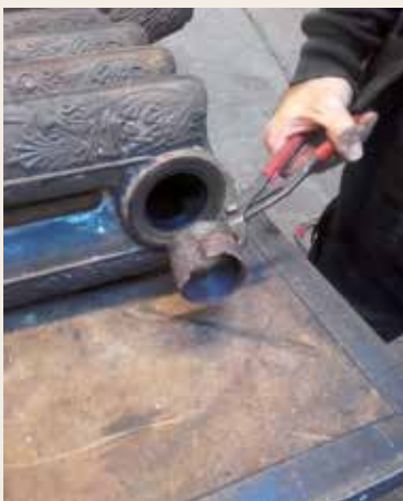
Demontage van de oude nippels (photo Desmée-Guillou).
