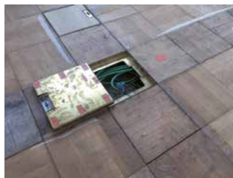
AFB. 4 Nieuwe vloerdozen ingewerkt in houten vloerafwerking (© Origin, 2019).
