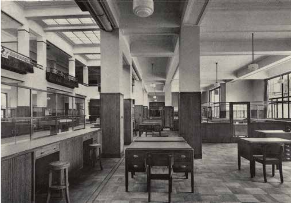
AFB. 5 Historische foto van de lokettenzaal. De plaats van de oorspronkelijke schakelaars en stopcontacten is zichtbaar (© Gemeente Vorst).
