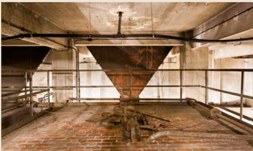
Reservoirtrechter waarin de steenkool werd gestort (© Helen Hermans).
