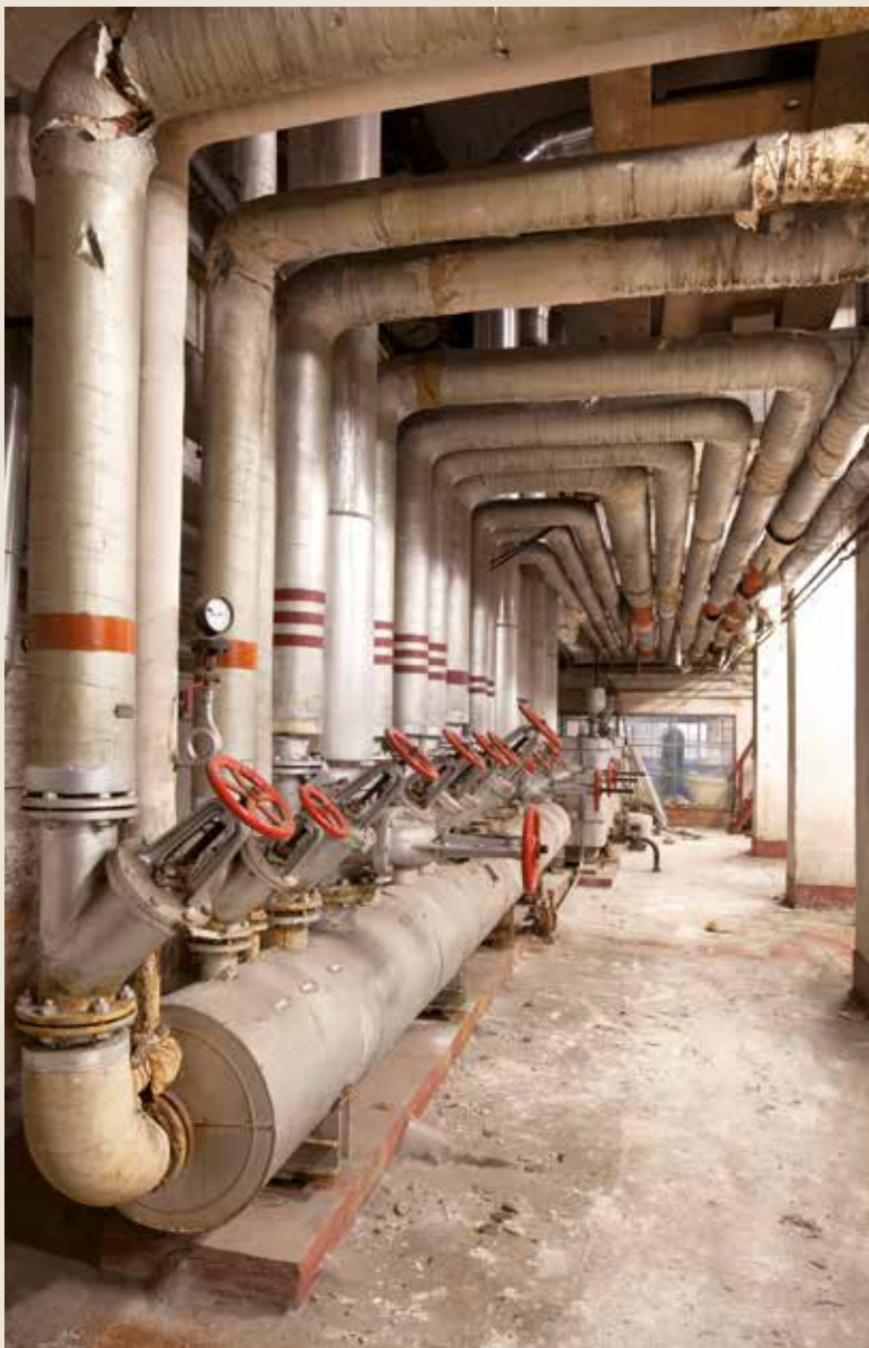
Netwerk van leidingen met kleppen waardoorheen het tot stoom verwarmde water liep (© Helen Hermans).
