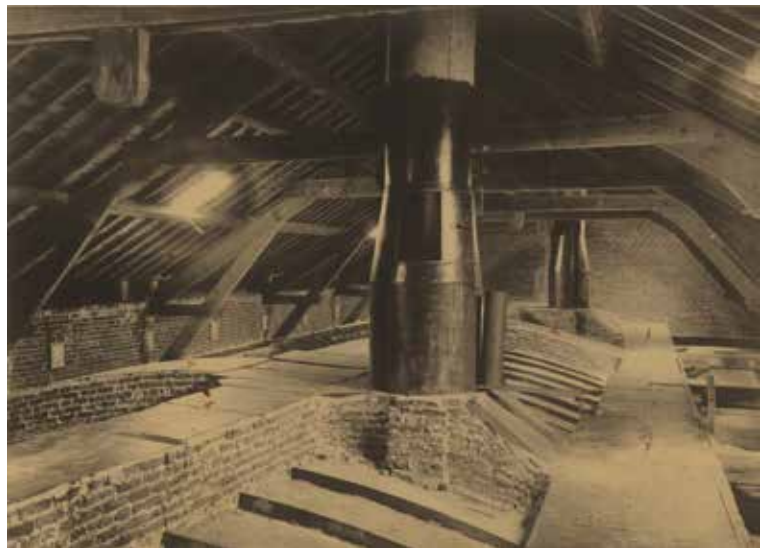
AFB. 6 Foto van het luchtextractiesysteem van het dodenhuis, genomen na de voltooiing van het gebouw, s.d. (© SAB).
