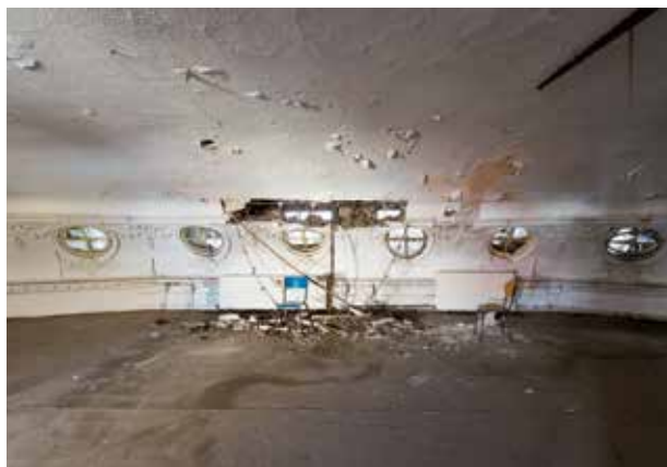
AFB. 11 Plafond van de Lodewijk XV-zaal, dat van de zaal werd afgescheiden door de toevoeging van een betonvloer in 1953 (© Marie-Françoise Plissart, 2015).
