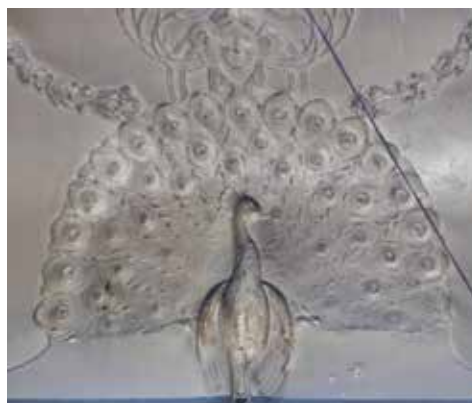
AFB. 9 Pauw in stucwerk boven de kroonlijst van de trappenhal. In het uiteinde van elke veer kon een gloeilamp ingedraaid worden (© MA2, 2009).
