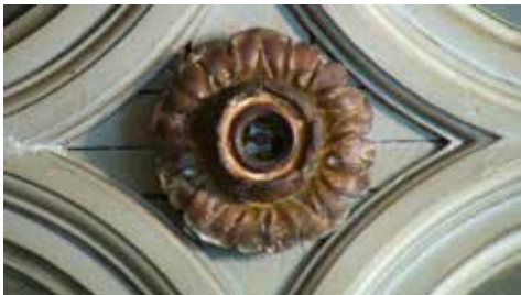
AFB. 6C Bloem in stucwerk in de gang waarin een porseleinen fitting is verwerkt (© MA2, 2015).
