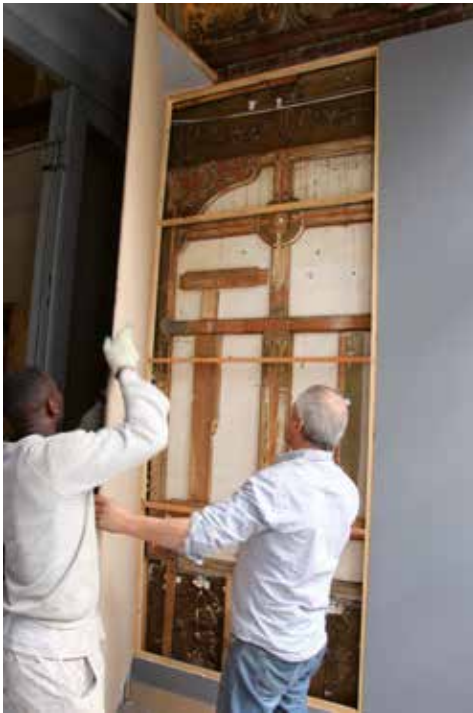
AFB. 6A Demontage van de bekleding in de gang waarachter zich sporen bevinden van de oorspronkelijke decors (© MA2, 2013).
