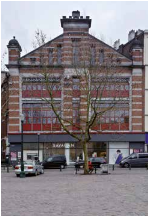
AFB. 9 Gevel van de voormalige machinezaal van de elektriciteitscentrale aan het Sint-Katelijneplein in Brussel. Architect Emile Devreux, 1901 (A. de Ville de Goyet © urban.brussels, 2015).
