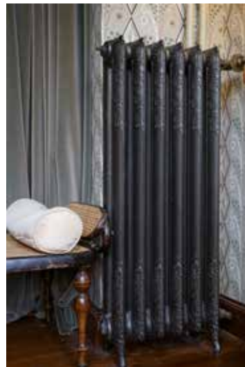
AFB. 23 De gietijzeren radiator leende zich uitstekend voor een esthetische behandeling en kon harmonieus in de binneninrichting worden ingewerkt. Huis Autrique, Brussel (foto van de auteur).
