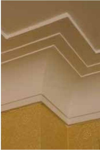
AFB. 15 Profiellijsten van het plafond van een eetkamer. Dit soort motieven, typisch voor de art deco, leenden zich een sterke en stabiele verspreiding van het licht. Particuliere woning, Brussel, 1926 (foto van de auteur).
