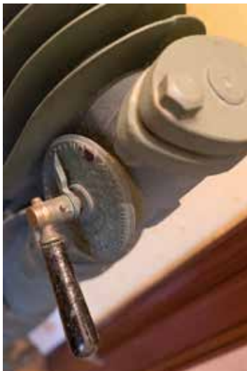
AFB. 22 Dankzij zijn grote efficiëntie was het verwarmingssysteem op stoom ideaal voor grote villa's en kastelen, vooral in koude en vochtige streken. Radiator van de centrale verwarmingsinstallatie op stoom van de Villa New Castle in Spa, 1900 (foto D. Houbrechts).
