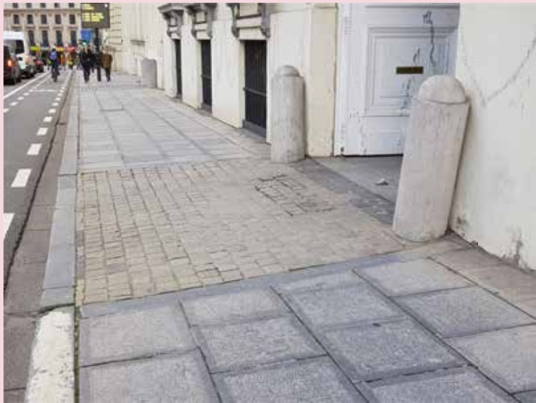
Schamppalen aan de ingang van de inrijpoort in de Wetstraat nr. 6. (foto van de auteur)
