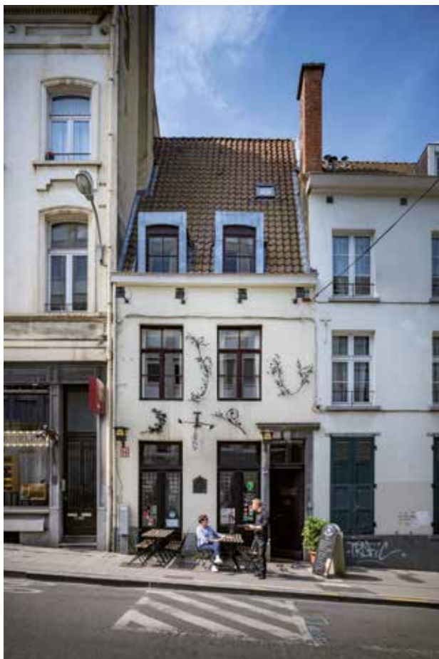
Gevel aan de Cellebroersstraat (© Lander Loeckx, 2019 / vzw Geert van Bruaene).
