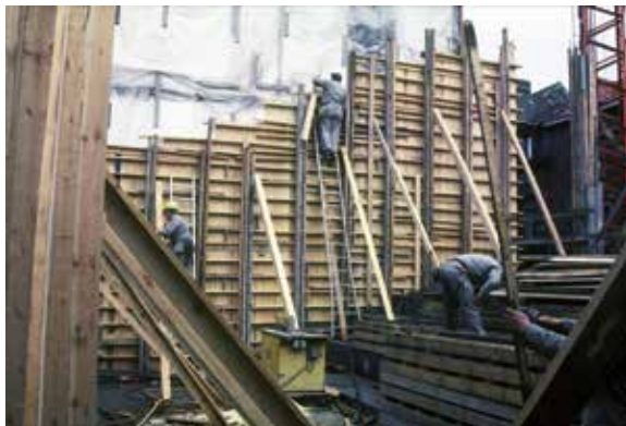
Afb. 14 Bekistingen van de betonmuur tegen de gemene muur, kant Ierlandstraat, 1989 (© AUCL, Faculté LOCI/Fonds Jean Cosse).
