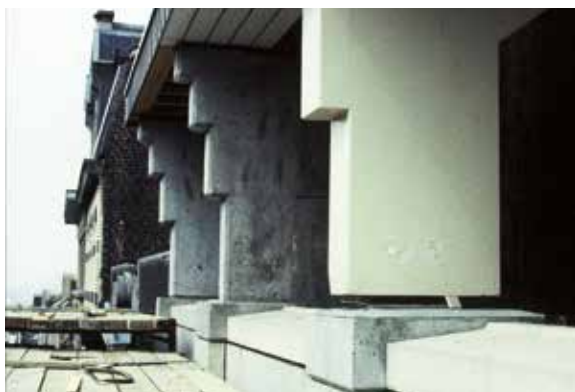
Afb. 21 Detail van de steunen van het dakgebinte en de kroonlijst, 1989 (© AUCL, Faculté LOCI/Fonds Jean Cosse).
