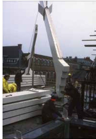
Afb. 18 Plaatsing van de prefabelementen van het dakgebinte op de hoek, 1989 (© AUCL, Faculté LOCI/Fonds Jean Cosse).
