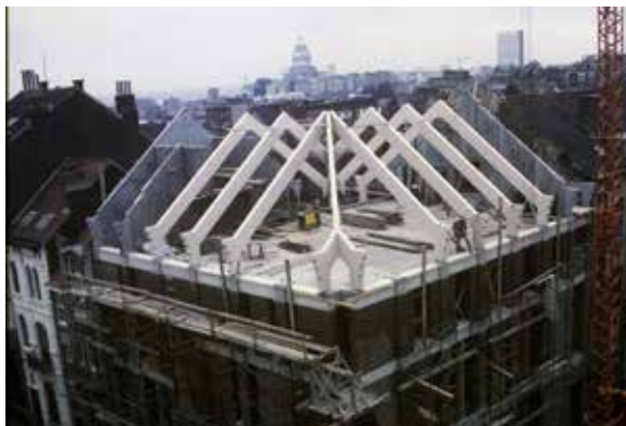
Afb. 19 Plaatsing van alle dakspanten. Panoramisch zicht, 1989 (© AUCL, Faculté LOCI/Fonds Jean Cosse).
