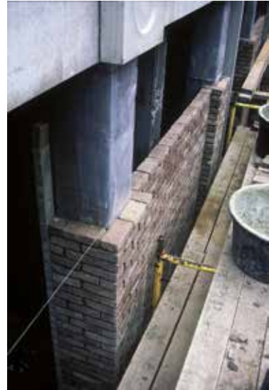
Afb. 11 Detail van de gevelmuur in aanbouw, 1989 (© AUCL, Faculté LOCI/Fonds Jean Cosse).
