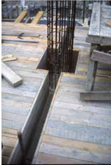
Afb. 9 Detail van de wapening voor de ronde kolom, 1988-1989 (© AUCL, Faculté LOCI/Fonds Jean Cosse).
