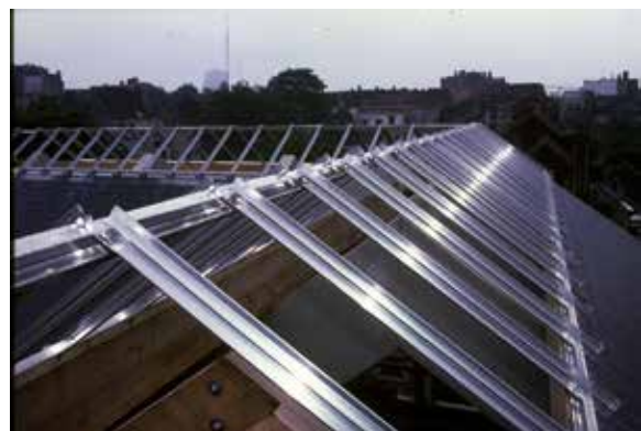
Afb. 22 De aluminiumstructuur van de lichtkoepel in de nok, 1989 (© AUCL, Faculté LOCI/Fonds Jean Cosse).
