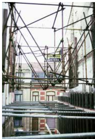
Afb. 3 Schoring van de gemene muur, kant Ierlandstraat, 1988 (© AUCL, Faculté LOCI/Fonds Jean Cosse).
