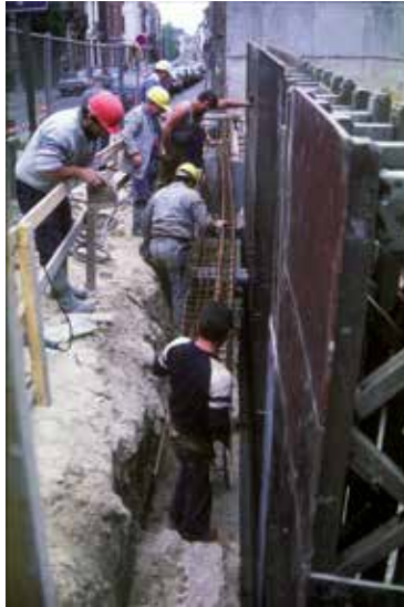
Afb. 10 Detail van de ringbalk van de kelders, 1988-1989 (© AUCL, Faculté LOCI/Fonds Jean Cosse).
