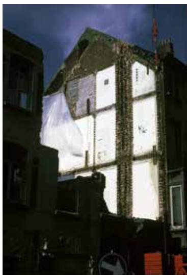
Afb. 2 Voorbereiding van de gemene muur, kant Maurice Wilmottestraat, voor de stapsgewijze stutting naarmate de afbraak vorderde, 1988 (© AUCL, Faculté LOCI/Fonds Jean Cosse).
