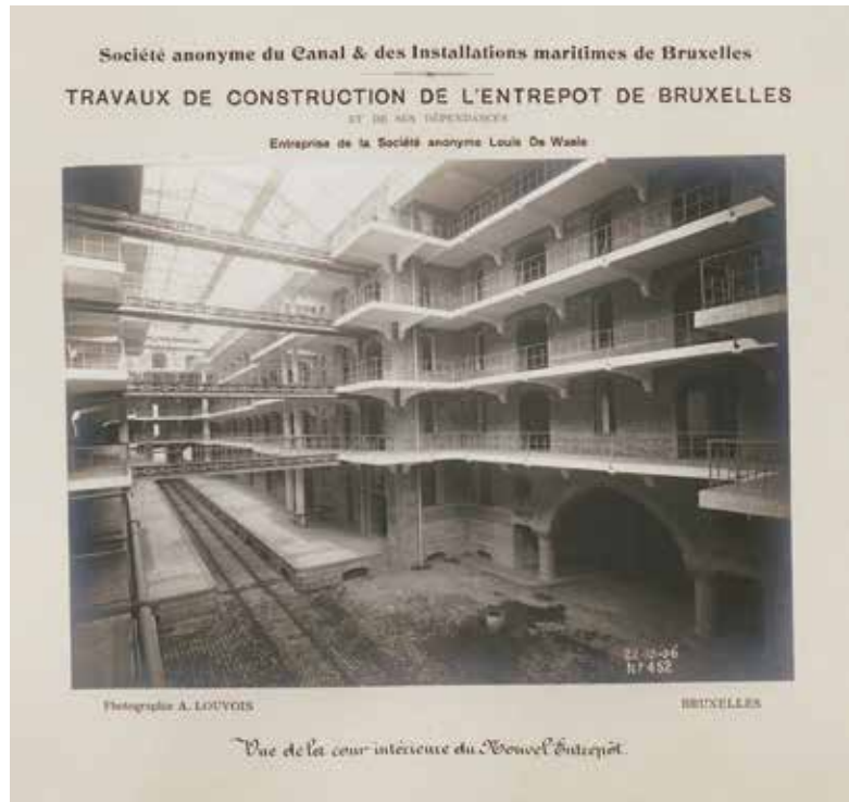
Afb. 4 Interieur van het Koninklijk Pakhuis van Thurn en Taxis met zicht op de overkragende dunne betonvloeren (SAB, Cl, M-80, foto van A. Louvois).
