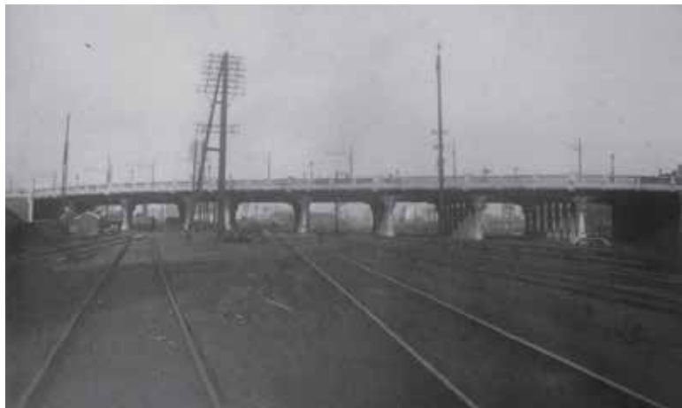
Afb. 6 Teichmanbrug in Schaarbeek (1905, gesloopt) (© Archives Blaton, Fondation CIVA Stichting).
