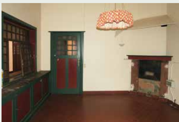
Afb.4b Detail van het originele kleurenschema op de binnendeur in dekkende en transparante olieverf (© Fenikx bvba, 2017).
