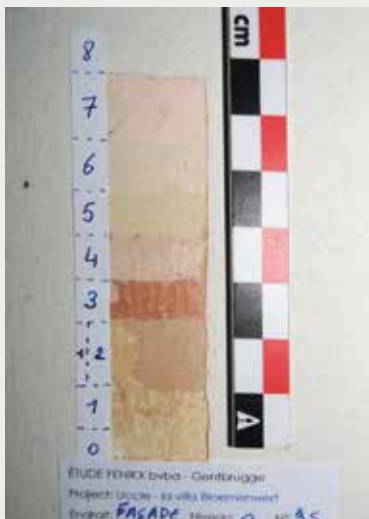
Afb.2 Steekproef (9S) op de voorgevel in de dagkant van een raam (© Fenixx bvba, 2017).
