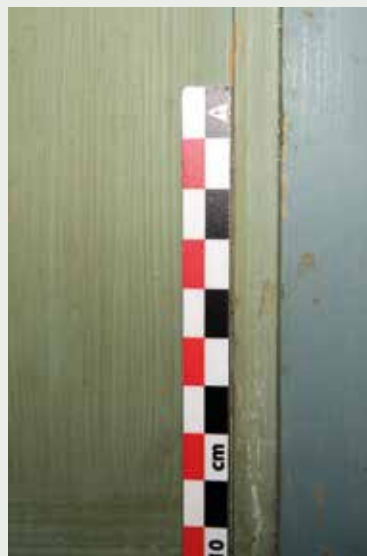
Afb.4b Detail van het originele kleurenschema op de binnendeur in dekkende en transparante olieverf (© Fenikx bvba, 2017).
