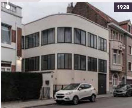
Atelierwoning van beeldhouwer Oscar Jespers (arch. Victor Bourgeois) Erfprinslaan 149 te Sint-Lambrechts-Woluwe B (totaliteit) 16/03/1995 (A. de Ville de Goyet, 2017 © BUP/BSE)
