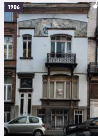
Atelierwoning van kunstenaar Alfred Ruytinx Voglerstraat 17a-17 te Schaarbeek BL (gevels, bedaking en totaliteit van het atelier) 18/12/1997 (A. de Ville de Goyet, 2018 © BUP/BSE)
