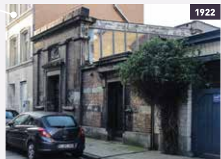
Atelier van schilder Herman Courtens (arch. Antoine Courtens) Braemtstraat 97-99 te Sint-Joost-ten-Node BL (straatgevel, dak en atelierkamer) 03/07/1997 B (gevel) 16/06/2005 (A. de Ville de Goyet, 2018 © BUP/BSE)
