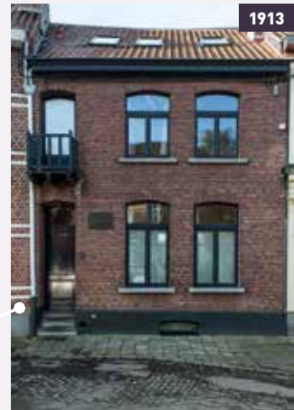
Atelierwoning en van schilder Rik Wouters Rik Woutersplein 7 te Watermaal-Bosvoorde BL (gevels, bedaking en delen van het interieur) 15/01/1998 (A. de Ville de Goyet, 2018 © BUP/BSE)
