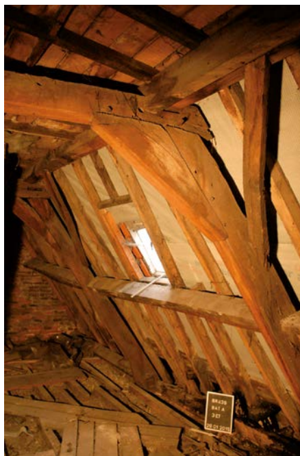
Afb. 6 Kapconstructie, Hoogstraat 178 in Brussel [S. Modrie © GOB-ULB].
