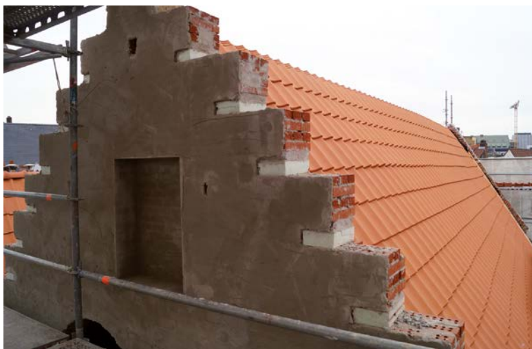
Afb. 5 Topgevel Boterstraat 30-32 in Brussel na reconstructie: de archeologische documenten zijn de enige getuigenissen van de 17de-eeuwse gevel, gereconstrueerd in moderne materialen (S. Modrie © GOB-ULB).
