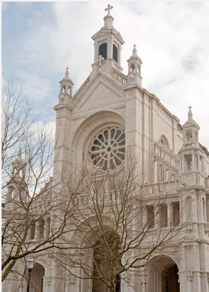
De gevel van de Sint-Katelijnekerk, na de restauratiecampagne van 2013 [A. de Ville de Goyet © GOB]
