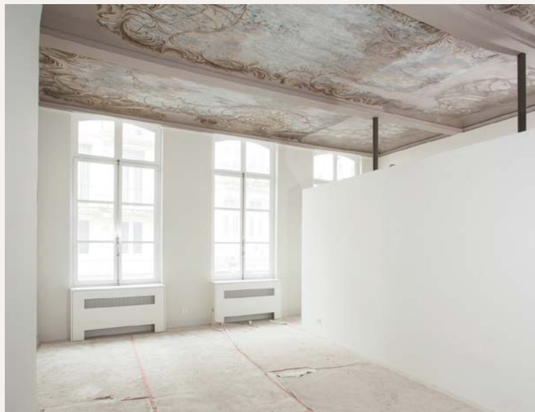
Het plafond na restauratie. Links het salon verlicht door de twee vensters, rechts achter de scheidingswand ligt een slaapkamer. Het lichtere gedeelte, aan de rechterkant van het plafond, is het deel dat overschilderd was en getoucheerd werd met gebruik van de trattegio -techniek (© KIK-IRPA, Brussel).
