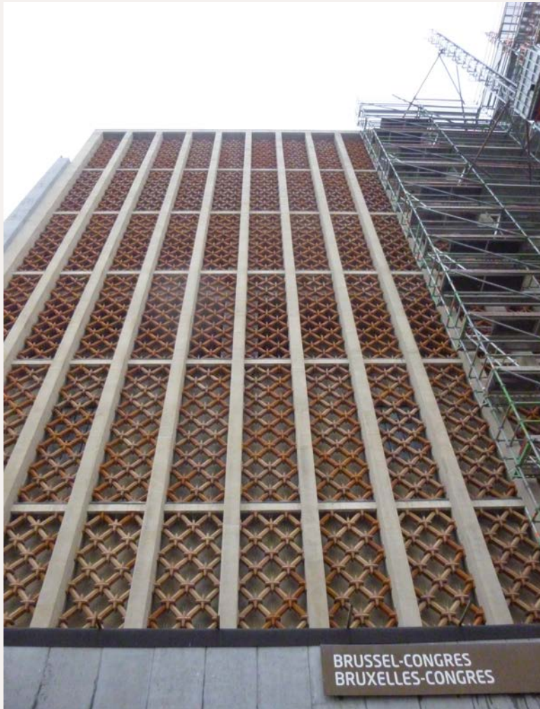
De gevel van het station Brussel-Congres met zijn parement van hardsteen en bakstenen claustra (© GOB).
