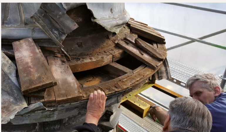
De ontmanteling van de loodbedekking van de lantaarn (© GOB).
