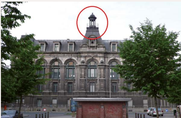
De gevel aan de straatkant voor de demontage van de lantaarn (© GOB).
