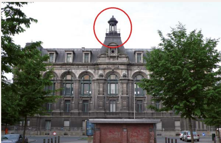
De gevel aan de straatkant voor de demontage van de lantaarn (© GOB).
