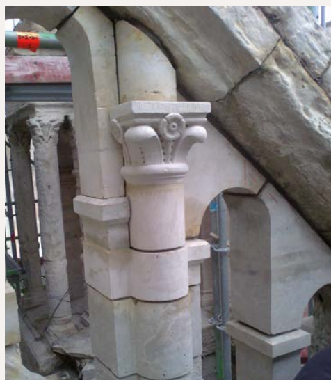
Herstellingen van de stenen ornamenten en consolidatie van de bestaande toestand, zelfs indien deze een zekere verwerking vertoonde. De centrale beeldhouwde elementen en kapitelen kregen meer aandacht dan verder naar achter of zijdelings gelegen elementen (© GOB).
