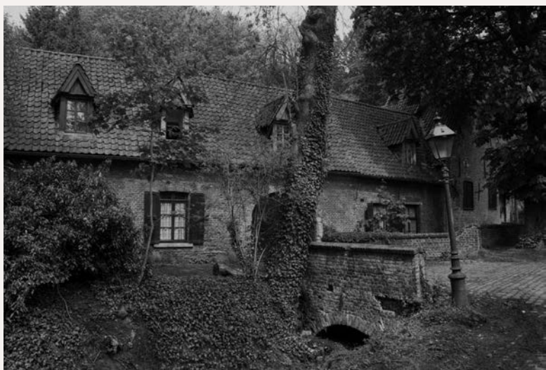
De Nekkersgatmolen voor restauratie (A. de Ville de Goyet, 2002 © GOB)
