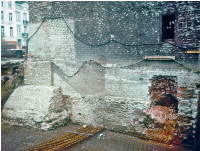
Afb. 12 Grondwerken voor het nieuwe technische lokaal van het museum van de Hallepoort (A. De Poorter, 1991 © KMKG).
